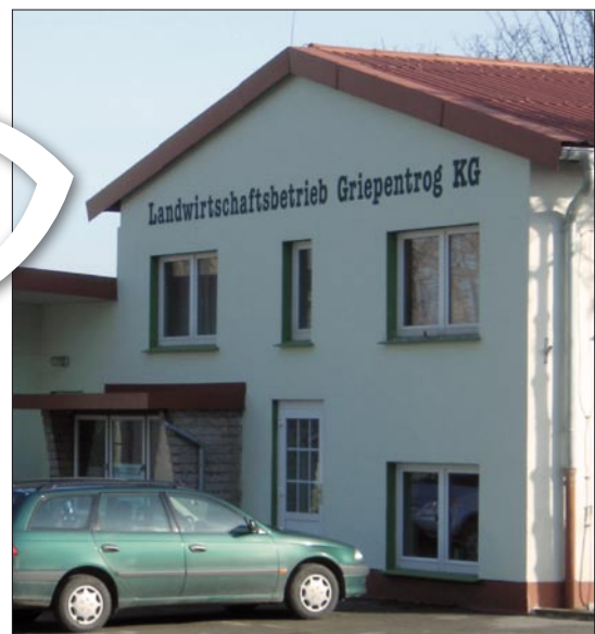
Das Verwaltungsgebäude der Griepentrog KG.
