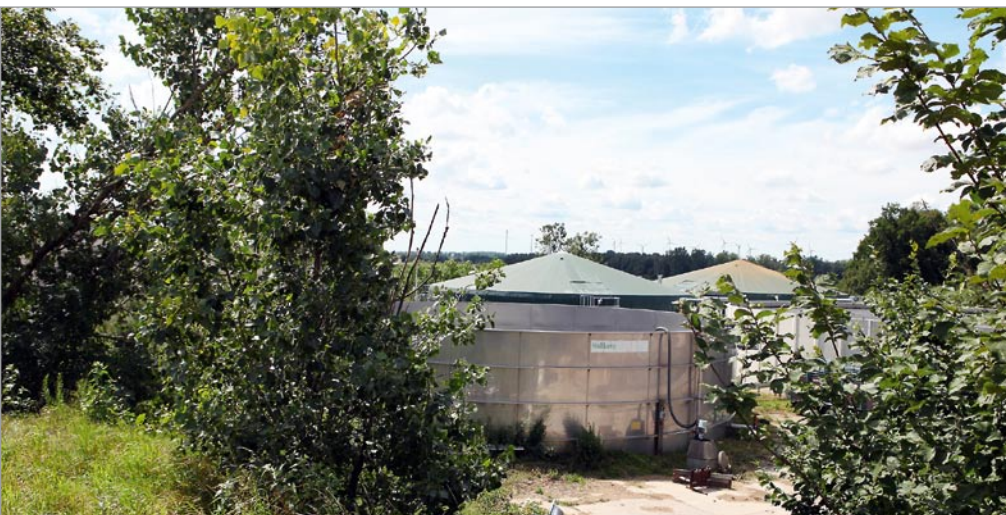
Eine der beiden Biogasanlagen der LPG 2000 Bioenergie GmbH steht in Zinzow.
