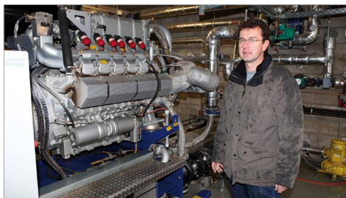
Das BHKW leistet 400 kW, erläutert Christian Schmidt. Biogas ist der jüngste Einkommenszweig im Unternehmen. Die Anlage vergärt vor allem Gülle, Mais und Gras und fügt sich so perfekt in den Produktionskreislauf ein.
