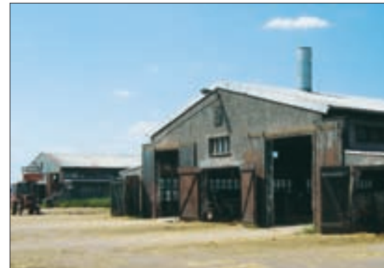
Die alte Milchviehanlage wird zum Teil abgerissen und zum Teil für das Jungvieh rekonstruiert
